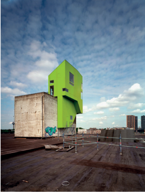
The Las Palmas Parasite van Korteknie Stuhlmacher Architecten werd in 2001 tijdelijk aan de betonwanden van een liftschacht van een voormalig pakhuis aan de Rotterdamse Wilhelminapier bevestigd.
